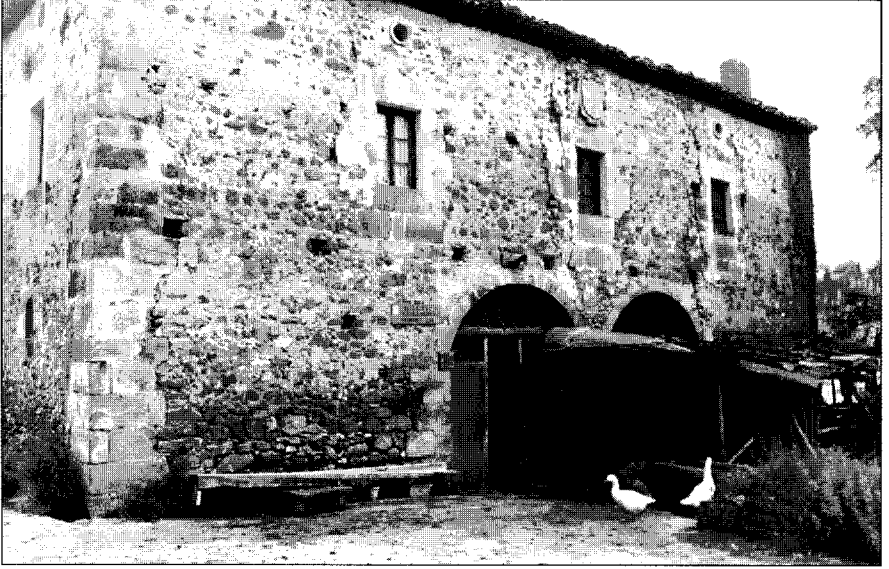
Areitzagabaso baserria (JLU 1996).
